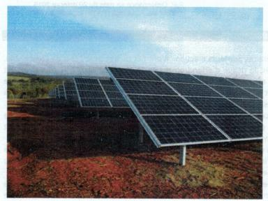
La puissance totale de ce parc est de 12 MWc répartie en 5 ensembles de puissance unitaire 2.4MWc. Chaque poste onduleur est connecté au poste de livraison. La Centrale sera raccordée au réseau électrique de distribution au travers d'une liaison 20kV.
